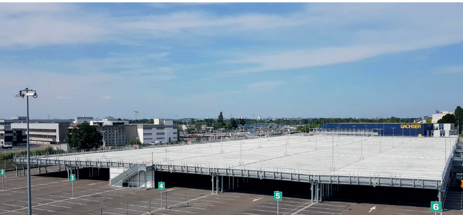
Nouveau parking silo « Park'up » de l'aéroport de Nantes (44) - Nextansia
