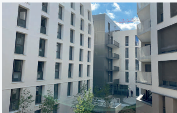
Côté Maine - AXEL Saint Serge Angers (49) - Angers Loire Habitat
